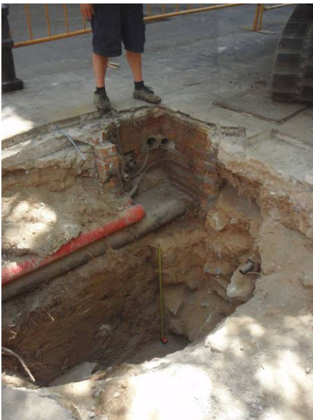
7. Mur UE 3 i estrat UE 5, escapçats per serveis actuals.
