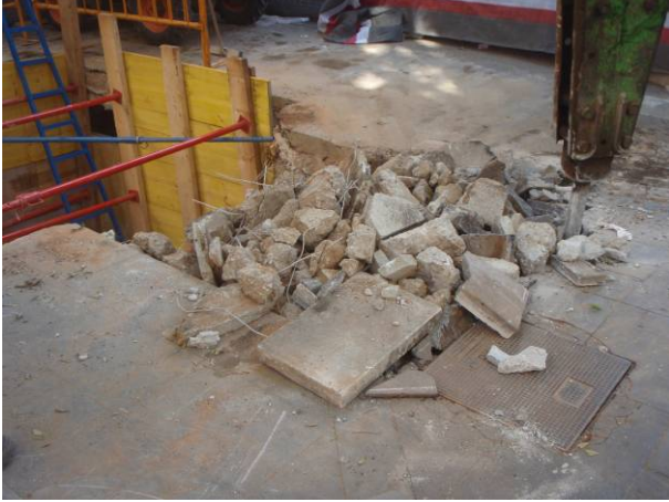
1. Retirada del paviment UE 1.
