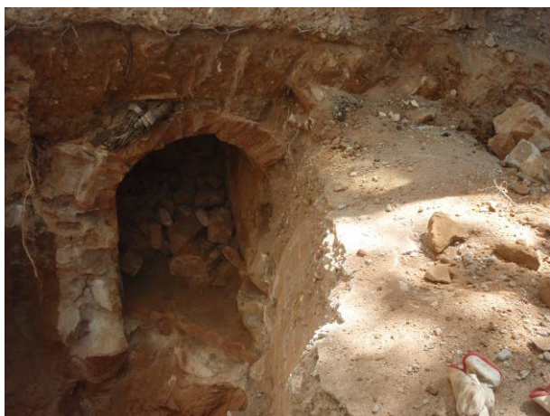
9. Claveguera inutilitzada..
